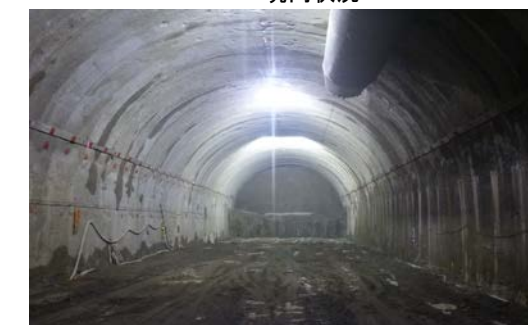
21.内浦トンネル(東川) 切羽状況
