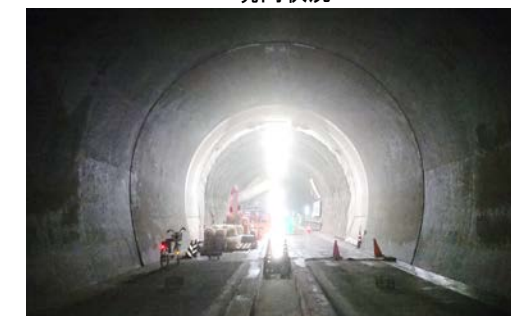
19.国縫トンネル他 坑内状況
