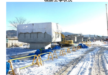
橋脚工事状況
